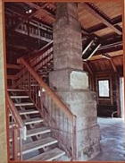
STATION KAPPELBERG, STEINPFLEILER IM ERDGESCHOSS DES AUSSICHTSTURMES.
