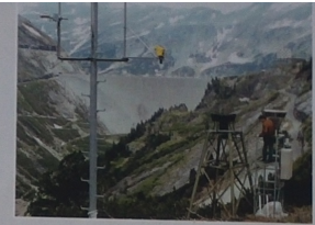
Wetterstation Kölnbrein Für die Bewirtschaftung der Stauseen ist die Fernübertragung der Temperatur- und Niederschlagswerte von großer Bedeutung. Wichtig ist dies vor allem bei Hochwasserereignissen.
