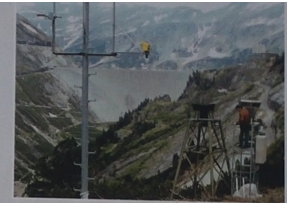
Wetterstation Kölnbrein Für die Bewirtschaftung der Stauseen ist die Fernübertragung der Temperatur- und Niederschlagswerte von großer Bedeutung. Wichtig ist dies vor allem bei Hochwassereignissen.
