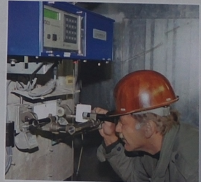
Lotmessungen Mit einem vertikalen Spanndraht werden die horizontalen Verschiebungen der Talsperre bzw. des Untergrundes erfaßt.
