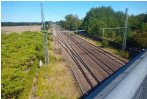
Die Strecke von der Brücke aus gesehen
