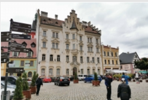
Hier ist schon so einiges saniert und sieht toll aus
